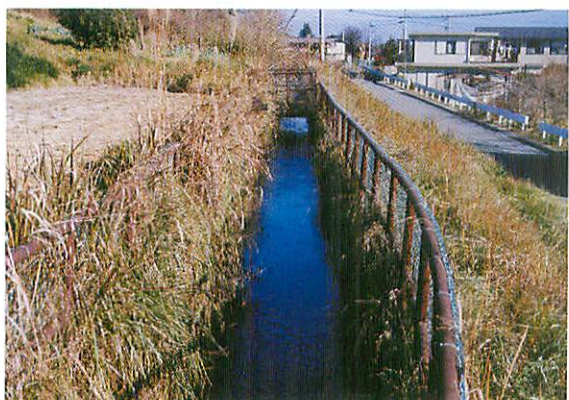
▲駄科寺下の竜西一貫水路
