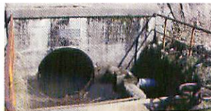
▲一貫水路中溝井分水槽
