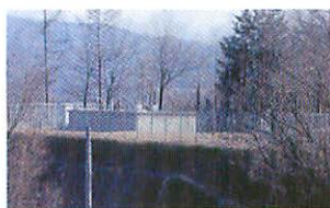
【写真3】上水道の水槽
