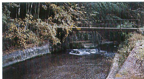
▲新川 発電所跡
