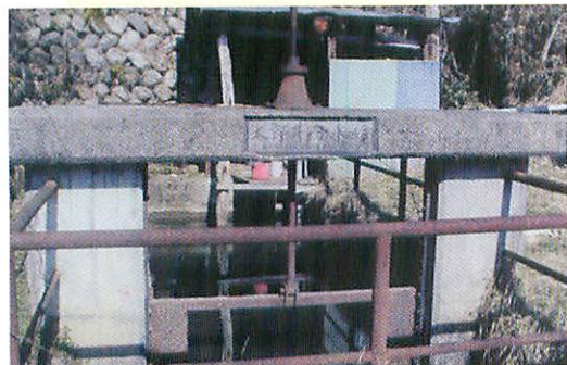
▲一貫水路の太郎井分水槽
