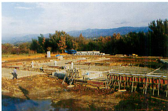
▲建設中の新竜丘公民館(平成12年11月)
