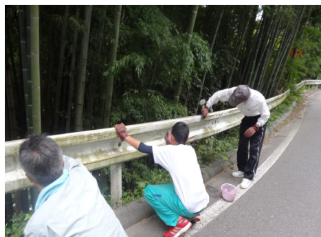
洗浄作業①
